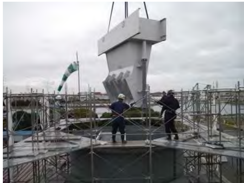
セトラ設置工事の様子
