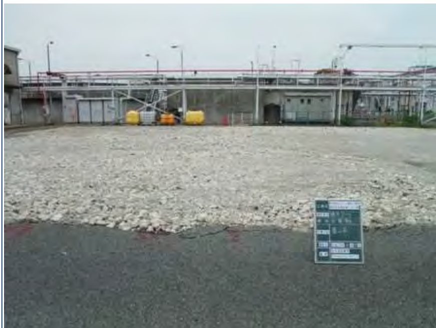
設置場所の様子
