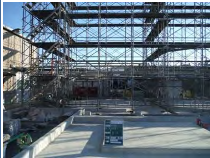
基礎工事の様子
