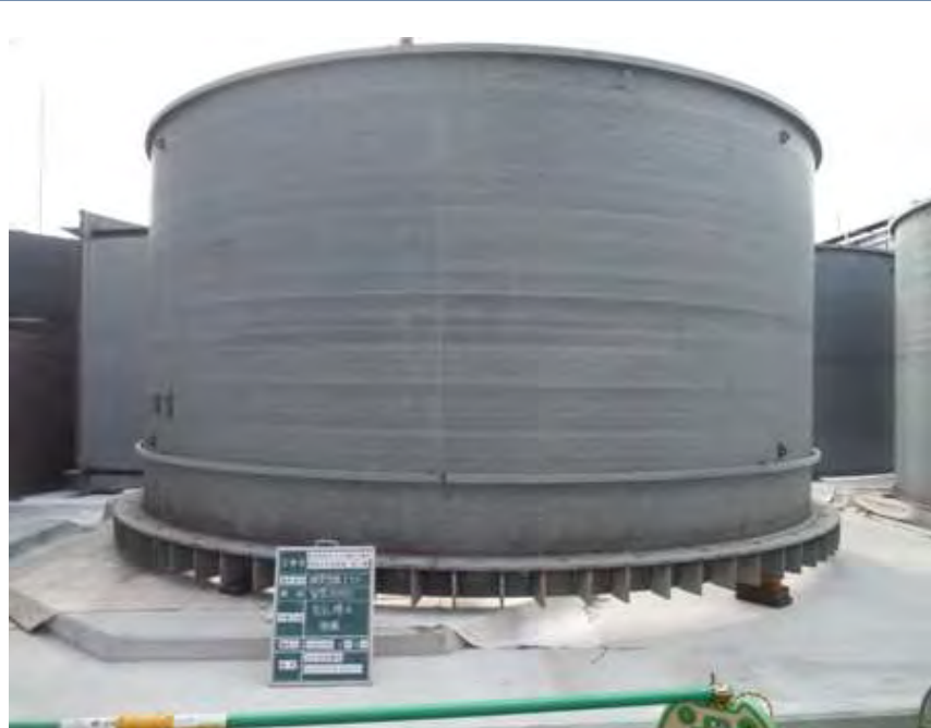
反応槽設置工事の様子
