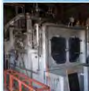
木質バイオマス発電
