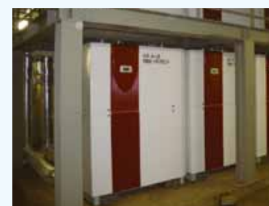
1. 水熱源ヒートポンプチラー 冷房能力 108.5kW
